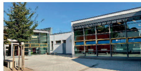
Das Bild zeigt den neuen Bauabschnitt von außen.
